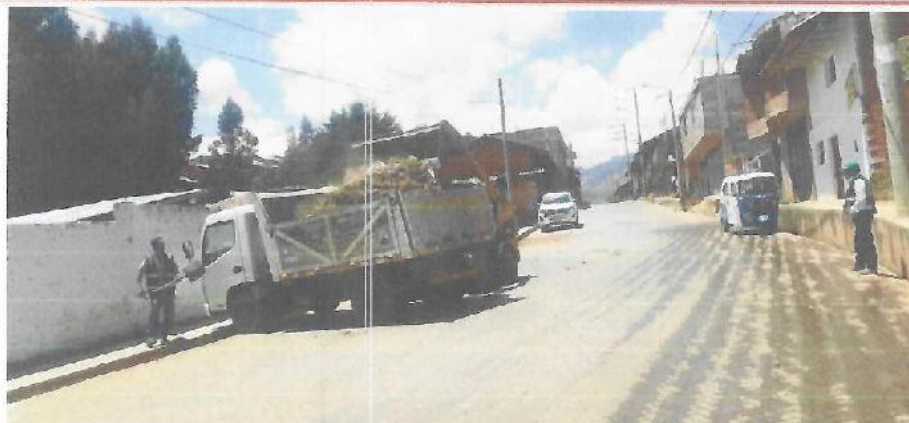
Limpeza de Cunetas
