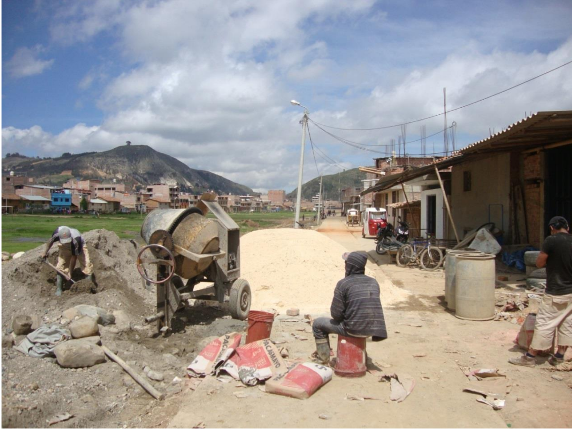
Figura 25: Construcciones en Purumpampa
