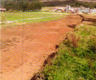
Trabajos de apertura de calle de 7 m de ancho por 1.2 m de profundidad y 400 m de largo aproximadamente para su mercado en el sector N° 1, en coordinación con el Área de Gestión de Riesgos de Desastres.
