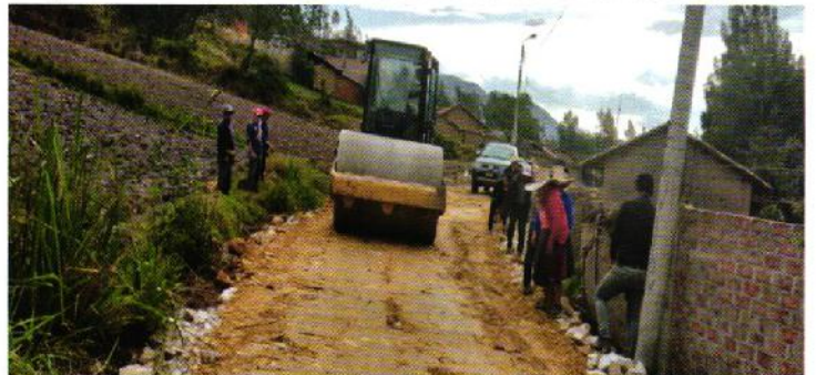
Mantenimiento de 9 kilómetros de calles con trabajos de enripiado de los diferentes sectores del caserío Paranshique
