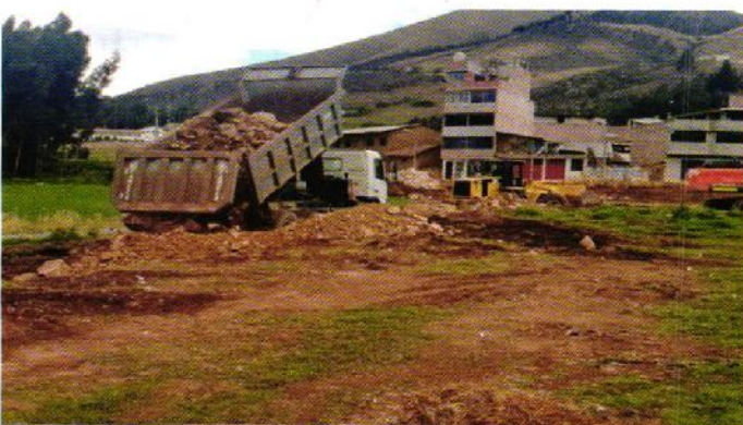
Trabajos de apertura de calle de 7 m de ancho por 1.2 m de profundidad y 400 m de largo aproximadamente para su mercado en el sector N° 1, en coordinación con el Área de Gestión de Riesgos de Desastres.
