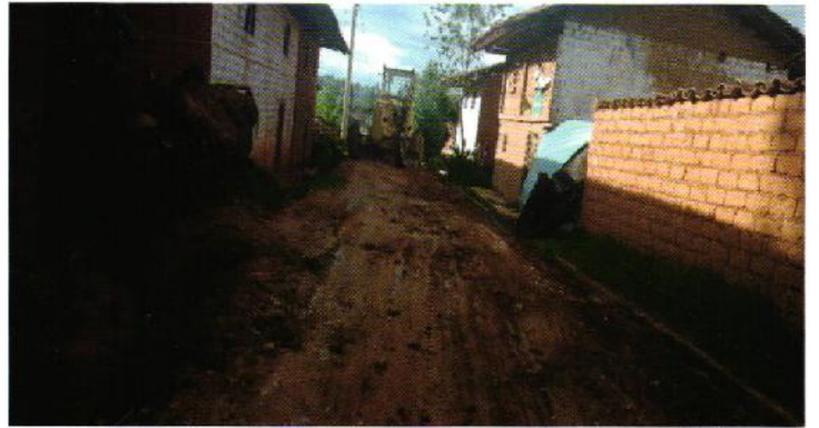
Mantenimiento de 9 kilómetros de calles con trabajos de enripiado de los diferentes sectores del caserío Paranshique
