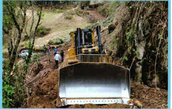
Apertura de trocha carrozable caserío Yamobamba - Hacienda Vieja parte alta, haciendo un total de 7 km.
